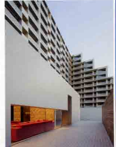
アネックス棟の通路から東・西棟を見る。手前はパーティールーム。
