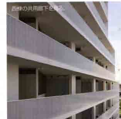
西棟の共用廊下を見る。
