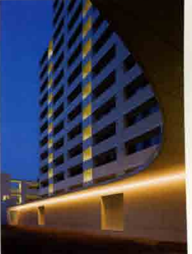
コートエントランスよりコリドーの外部を見る。奥に低層棟が見える。照明計画は内原智史デザイン事務所。
