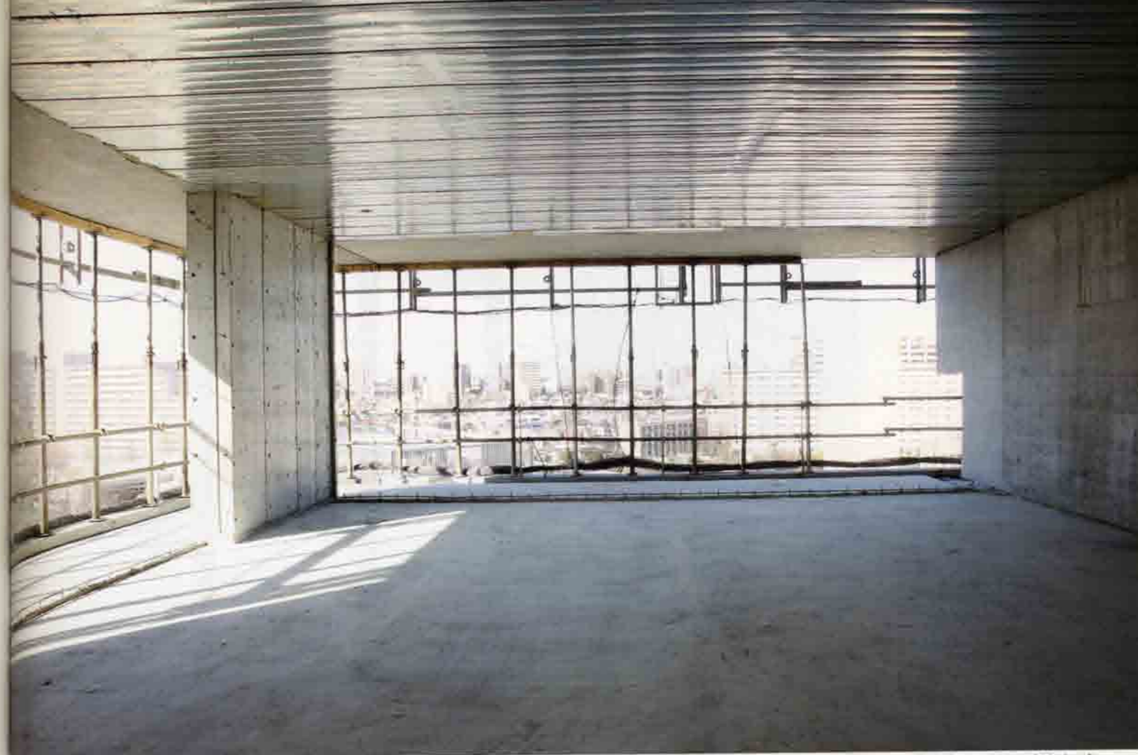
施工中のスケルトンのスケルトンの状態。床・壁・天井の厚さはそれぞれ270mm。バルコニーと戸境袖壁はプレキャストコンクリート。
