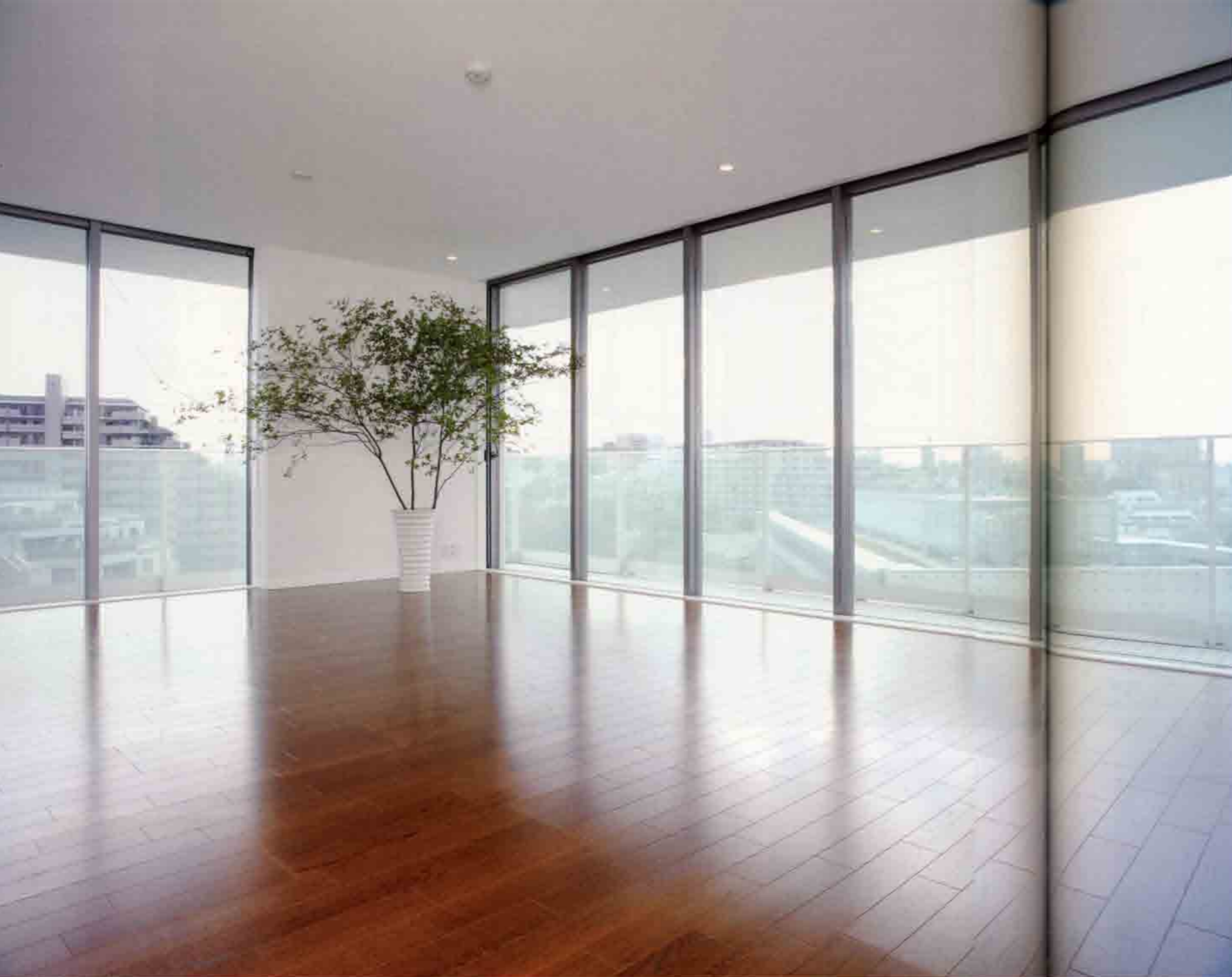
南棟住戸のリビングルーム。柱梁の出ない壁式構造で、開口部は全面窓となっている。開口部の高さは2,500mm、陽極酸化塗装複合皮膜を施したフルハイトのアルミサッシを用いている。床は天然木化粧接合フローリング。*
