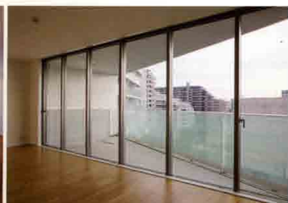
西棟住戸の三角形のバルコニーを見る。ガラス手摺りにはドットパターンのセラミックプリント。壁沿いにアルミルーバーを用いた特注の室外機置き場。
